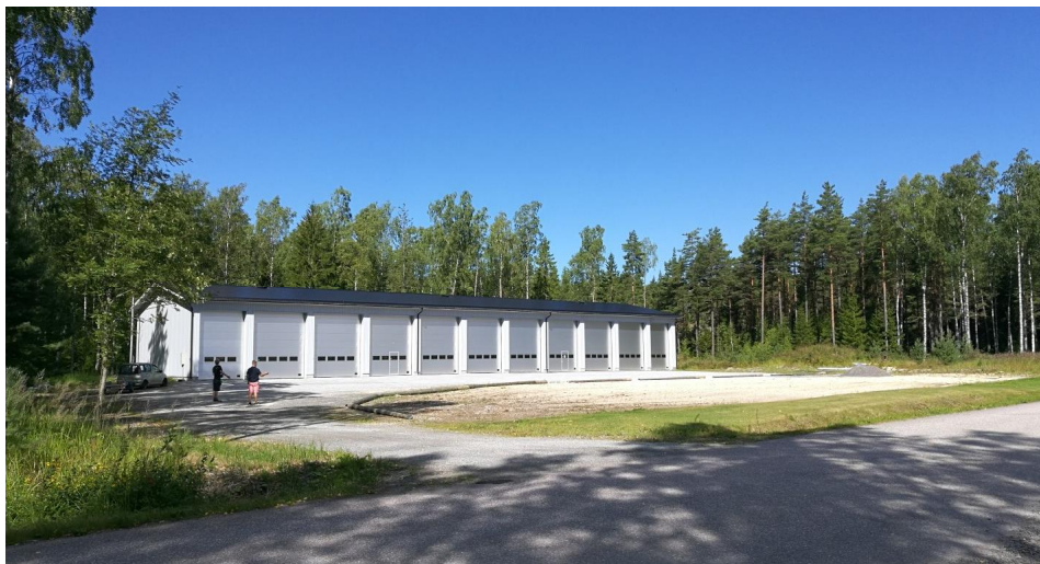
Fotografi 8. Bild av hallen på andra sidan av Järnösundsvägen.
